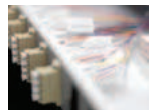
Панель FCP3D с четверными проходниками LC
